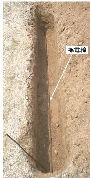
幅30cm深さ75cm以上の施工に必要な長さを掘削し、接地線を中心に置きます。
