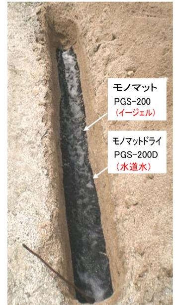
接地シート・モノマットの上から更に、低減材イージェルを投入すると、低減効果が増大します。
