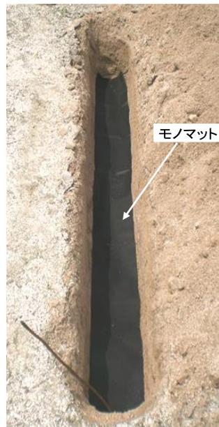
接地シート・モノマットに接地線を挟み込むか覆い被せるか状況に合わせて施工します。
