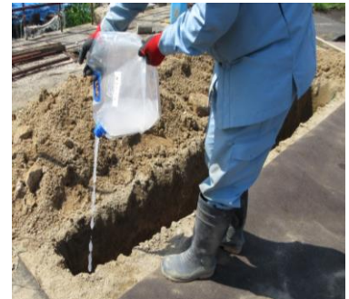
〔パイプアース工法に漏斗を使用〕
