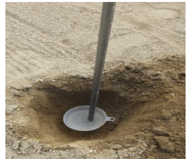
〔パイプアース工法に漏斗を使用〕
